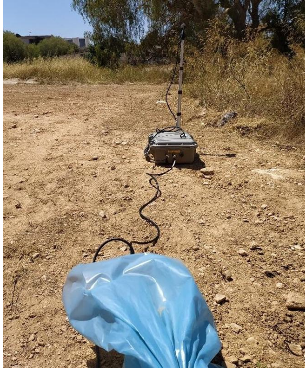
Σχήμα 2.3-4: Σταθμός μέτρησης παρακολούθησης δονήσεων
