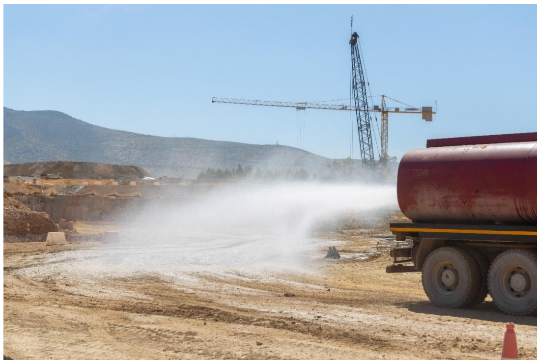
Σχήμα 2.2-5: Άποψη διαβροχής εργοταξιακών οδών
