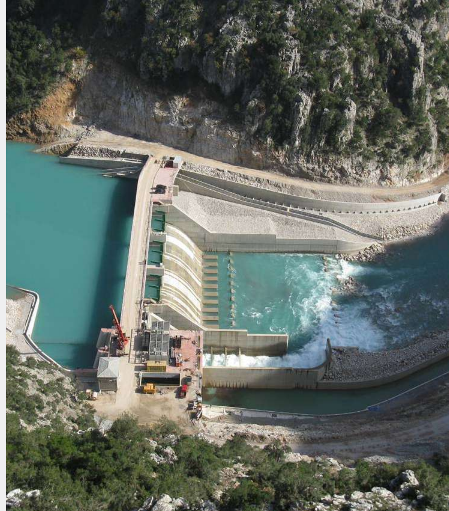
Υδροηλεκτρικό Έργο Δαφνοζωνάρας
