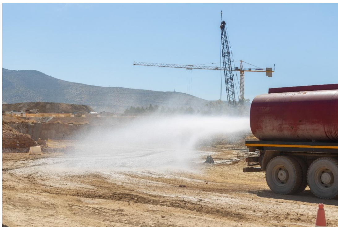
Σχήμα 2.2-5: Άποψη διαβροχής εργοταξιακών οδών
